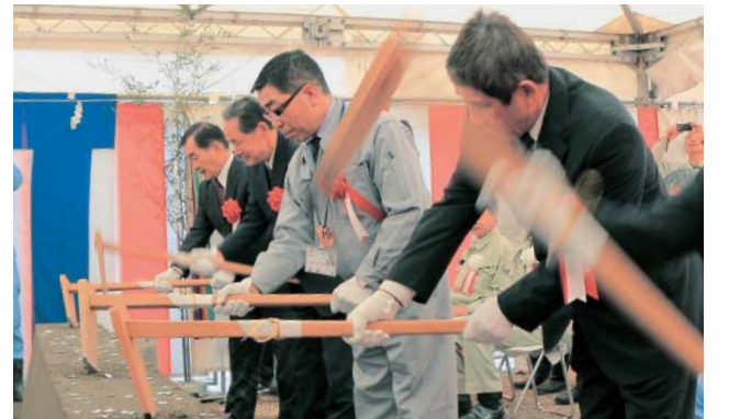
鍬入れをする工事関係者
