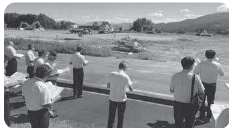
株式会社ランバーやまとが木材製材施設装置の設置を予定している中核工業用地
