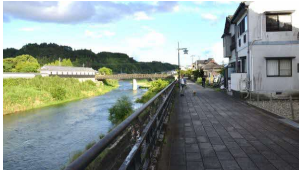
[左：胸川沿いの道路現況]
