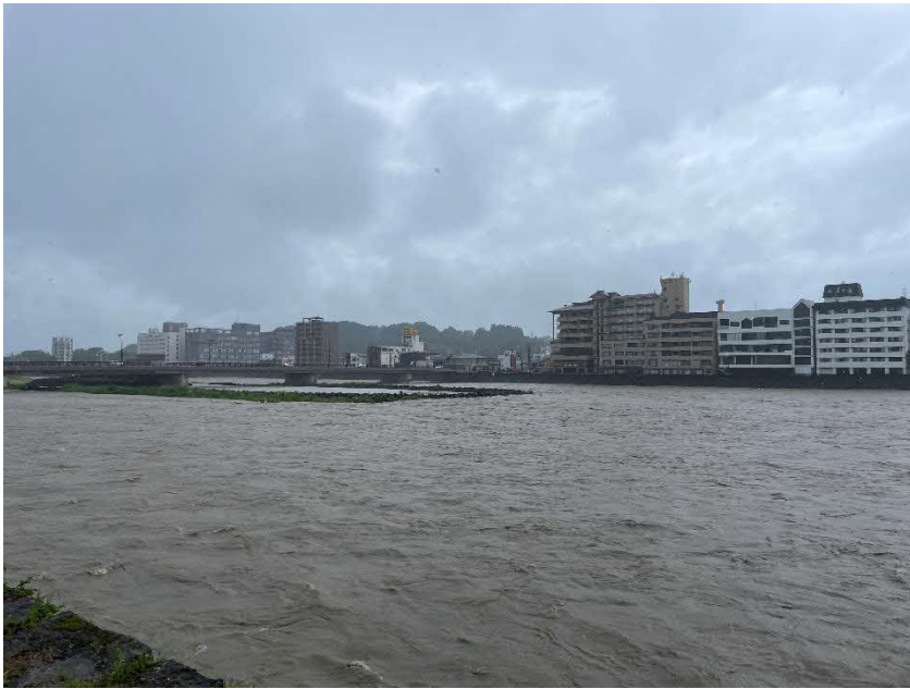
中川原浸水状況（R5.7月）
