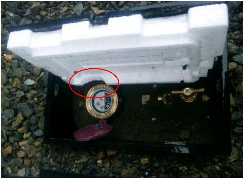
どうしても量水器のフタが保温材に接触する場合は、給水管を下げる等の対応を行ってください。
