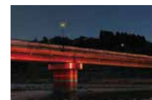
◀水の手橋に設置したライティング防災アラートの点灯訓練も行います（午前9時50分、午前10時30分）
