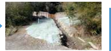
復旧完了(令和4年3月)
