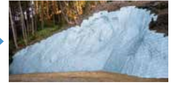
のり面復旧完了(令和4年3月)
