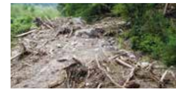
荒野(古仏頂町)の被災状況
