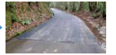
舗装復旧完了(令和4年2月)
