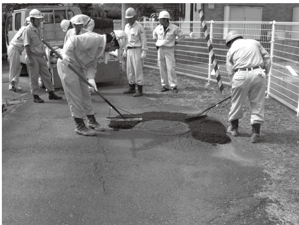
■マンホールまわり補修工事(下水道の日)
