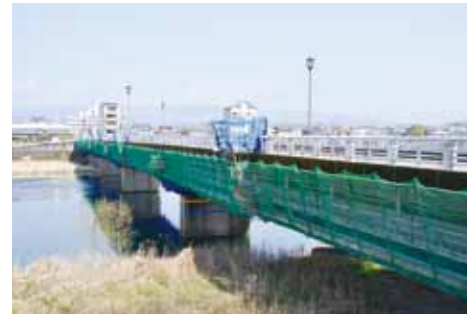
補修工事を進めている水ノ手橋
