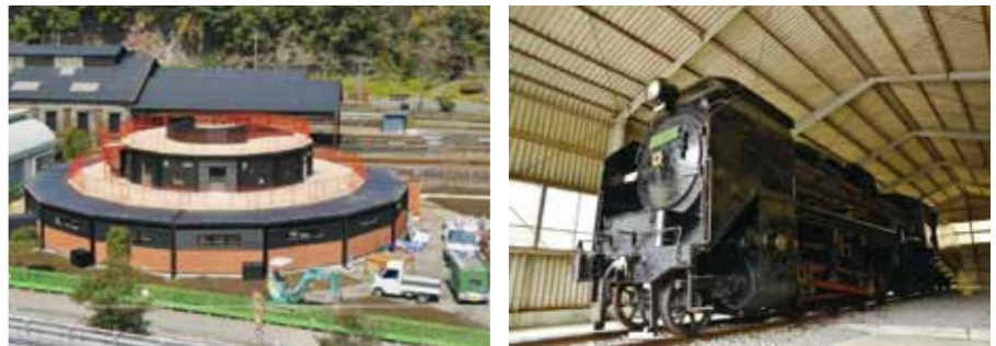
建築が進む鉄道ミュージアム
