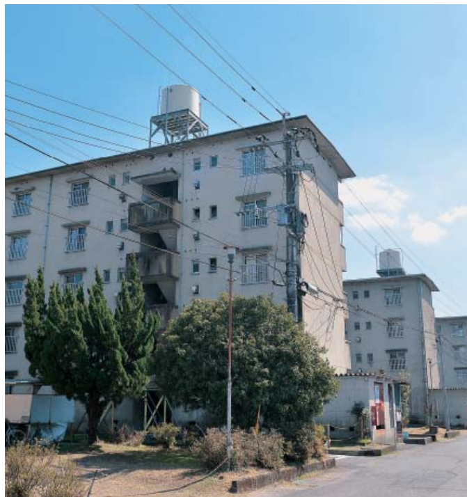
今後改修工事を進める鶴田団地
