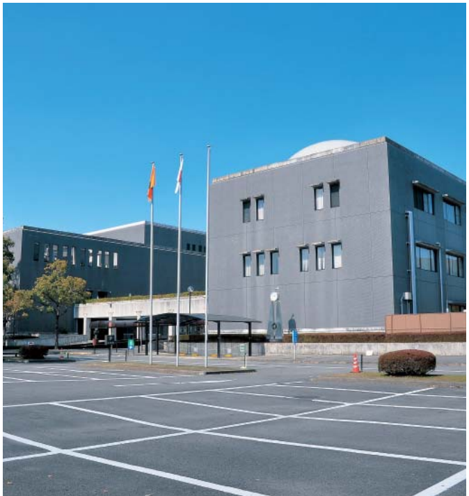
施設の改修が進むカルチャーパレス
