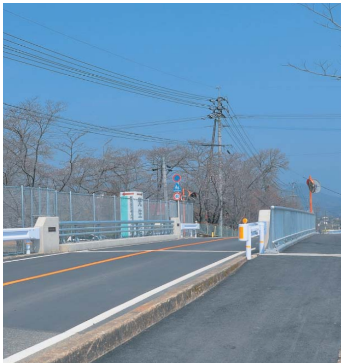
工事が終了した中原跨線橋
