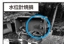
落雷被害があった大畑配水池の計器類
