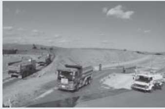
土砂搬入が進む人吉中核工業用地（上漆田町）
