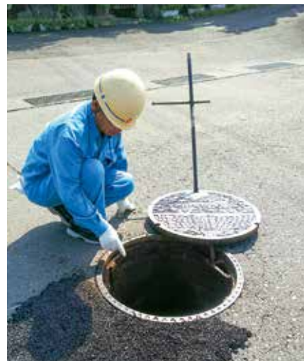
▲災害協定に基づいた、マンホールの確認調査
