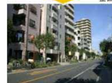
沿道建築物の不燃化 整備後
