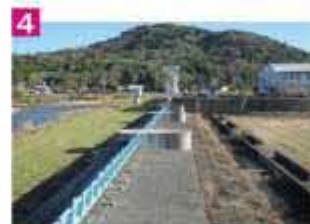
4 越流堤 【延長70m】 牛津川の水位が高くなったら、ここから遊水地内に水が入ります。
