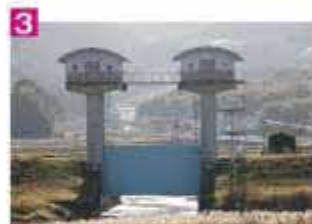
3 水門 【水門幅12m】 洪水時には水門を閉めて、牛津川の水が遊水地内に逆流するのを防ぎます。
