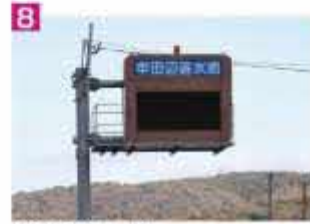
8 情報標示板 大雨の時、川の状況や牟田辺遊水地内の道路の浸水情報等をお知らせします。
