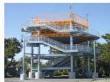
津波避難タワー
