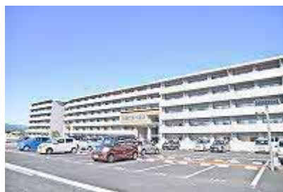
災害公営住宅
