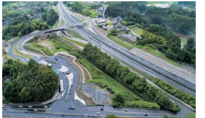
開通を間近に控え工事が進む
