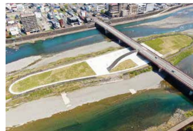
▲地面を2ヵ所掘り、芝生や歩道を整備
