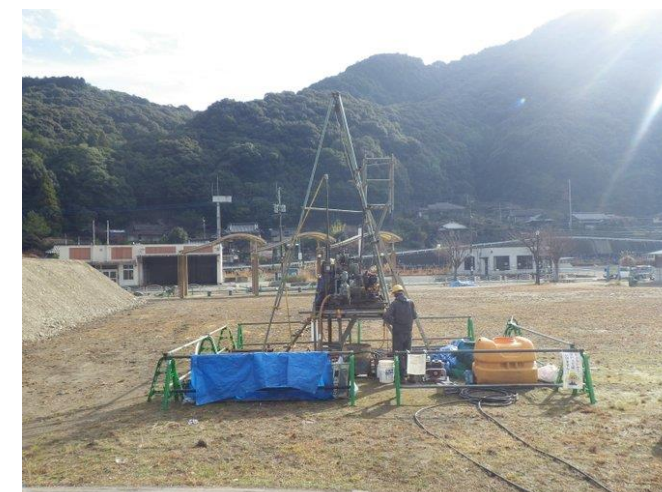
地質調査の状況【八代市坂本地区】
