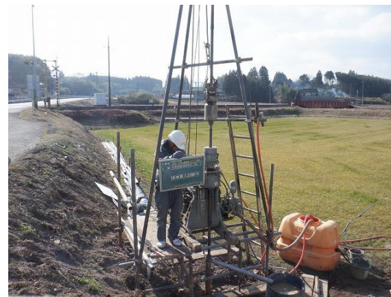
地質調査の状況【錦町】
