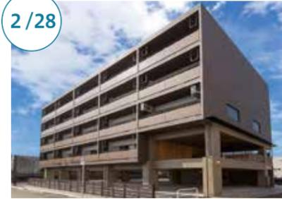
九日町と大工町の2団地に合計44戸の災害公営住宅が完成。鉄筋コンクリート5階建てで屋上には太陽光発電を設置しました。
