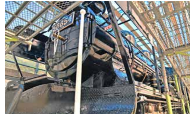
足場を組んでの塗装作業
