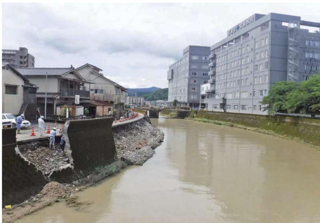
写真-2.4.44 山田川左岸部の護岸の被害
