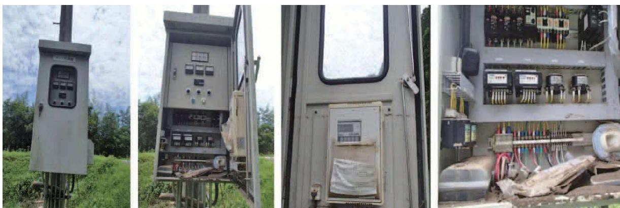
写真-2.4.7 山江村万江のポンプ施設の被害状況
