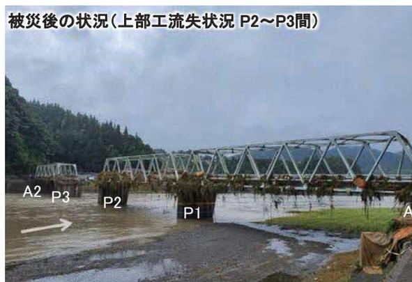
写真-2.4.9 西瀬橋の被災状況その2<sup>4)</sup>
