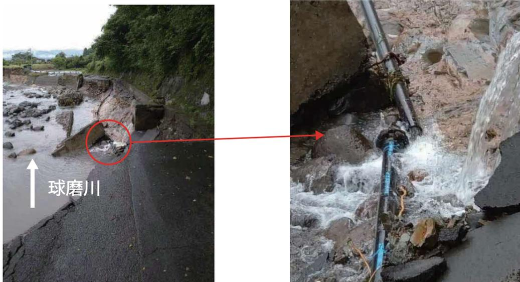
写真-2.4.2 下戸越町での配水管の破損
