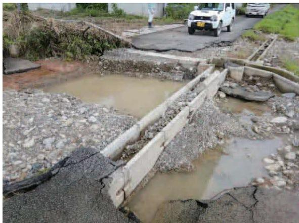
写真-2.4.49 農道の被害例
