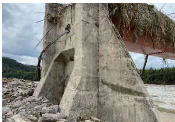
写真-2.4.13 天狗橋の被災状況その4
