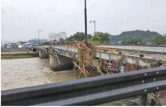
写真-2.4.14 大橋の被災状況その1
