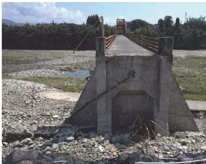
写真-2.4.1 天狗橋左岸取付部の破損により配水管流失
