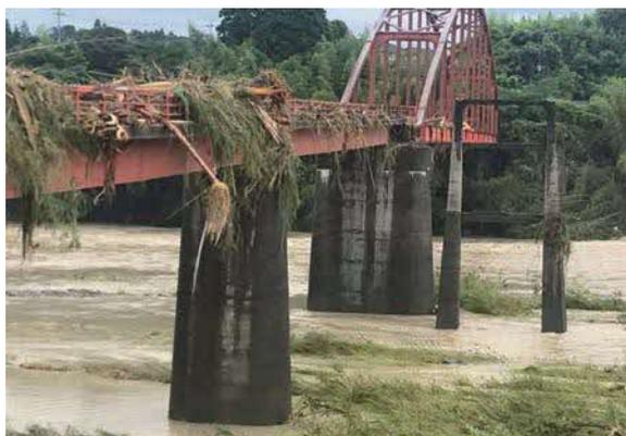
写真-2.4.10 天狗橋の被災状況その1
