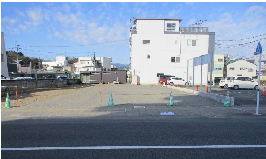
3 - 1 街区 宅地造成
