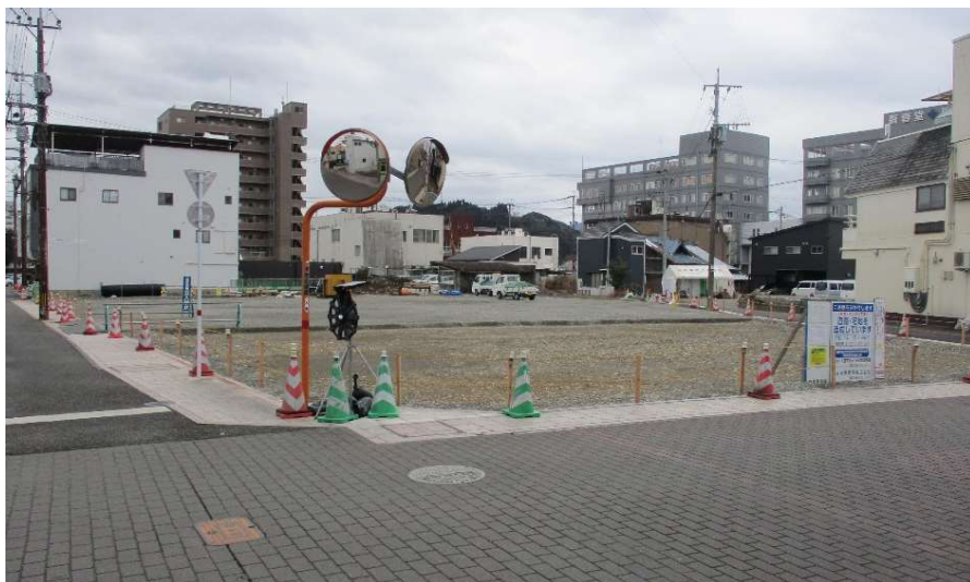
2 街区 宅地造成
