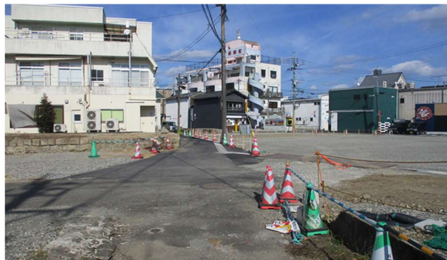
特4 - 2号線施工状況 (1街区と2街区の間)
