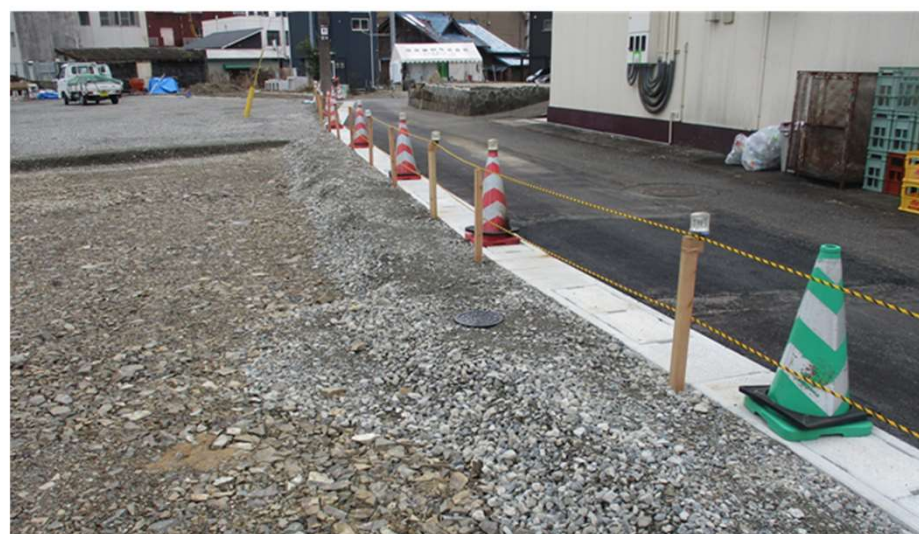
特4 - 2号線側溝敷設 (1街区と2街区の間)
