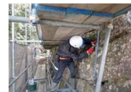
北東隅石垣間詰補修工事中
