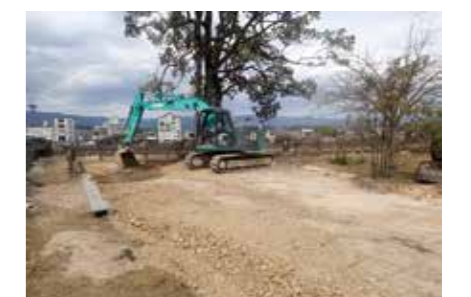
北外曲輪(きたそとくるわ) 陥没災害復旧工事中
