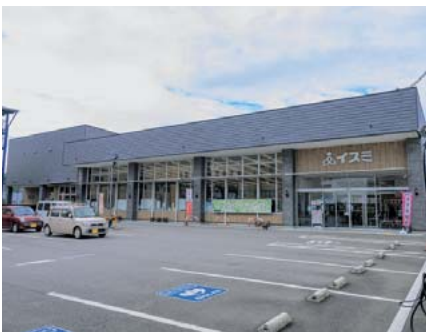
▲令和2年7月豪雨では商品や設備が水に浸かったが、被災後は近くの仮店舗で営業しながら、同じ場所に再建した
