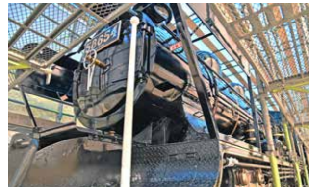
足場を組んでの塗装作業
