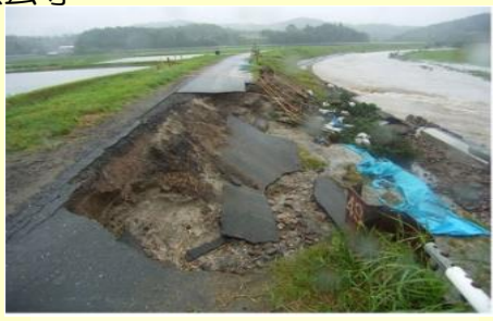
堤防、護岸等の災害復旧
