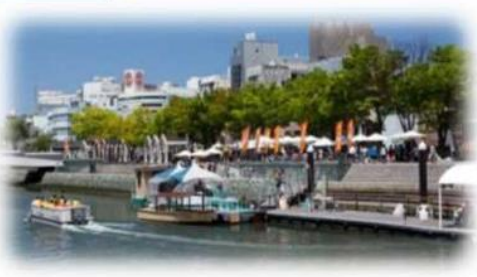
親水護岸の利用 (新町川／徳島市)
