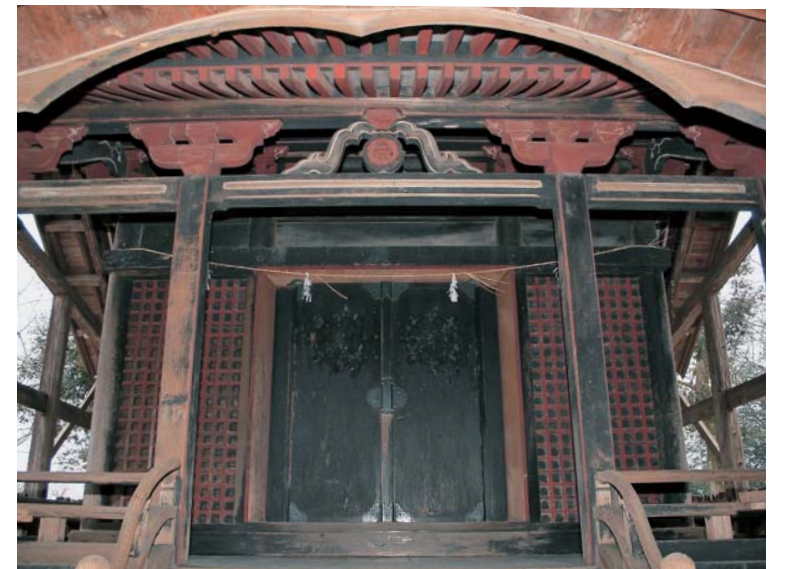
▲県重要文化財に指定されている井口八幡神社本殿
