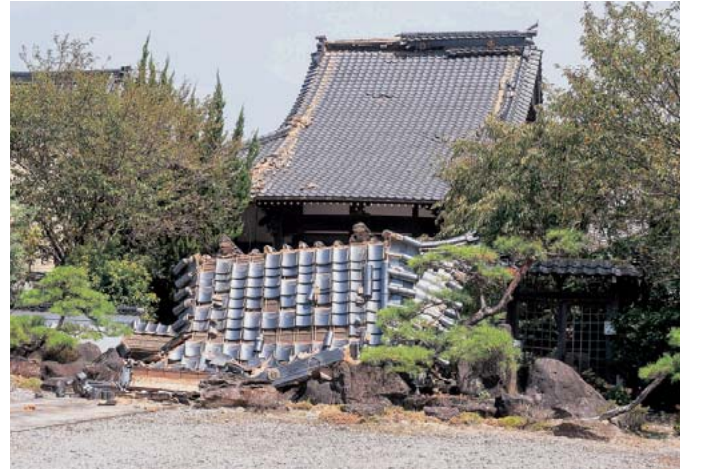
最大震度7の地震で家屋が崩れるなど大きな被害を受けた八代郡氷川町の被害状況
