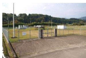
井ノ口第2水源地
