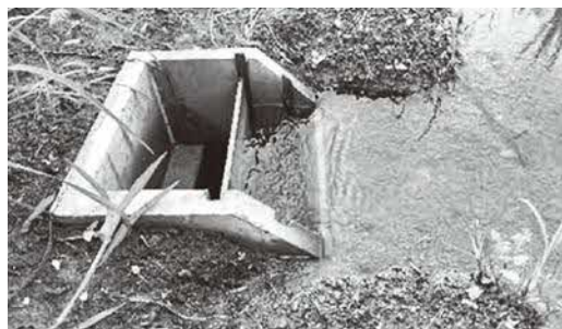
田んぼダム用のせき板を設置した排水枡
