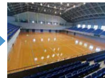
改修完了（令和4年3月）
