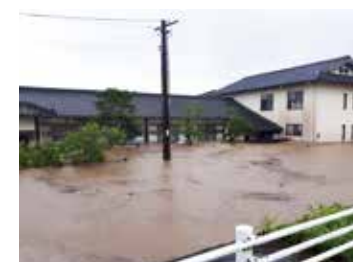
西瀬コミセンの被災状況
