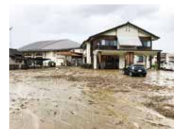
東西コミセンの被災状況
