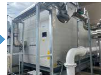
改修完了（令和4年3月）
