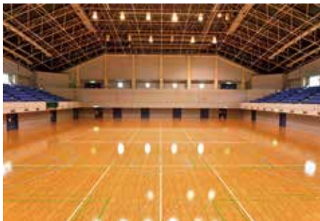
改修工事を終えたスポーツパレス大アリーナ
