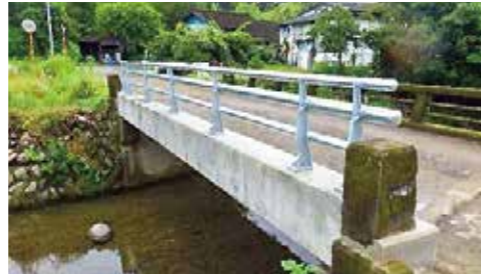
復旧完了（令和3年6月）
