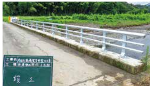
復旧完了（令和3年6月）
