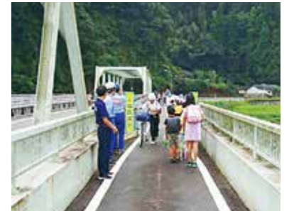
仮橋設置による開通（令和2年9月）
