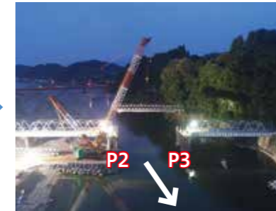
応急復旧（仮橋設置 令和2年8月）
