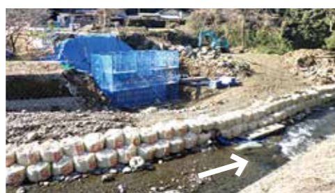
下部工施工中
