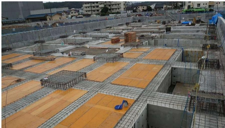
↑免震装置を配置する免震層の床部分です。正方形の台座のように鉄筋が組んである部分が免震装置が設置される基礎部分になります。12月上旬にコンクリート打設を完了し、中旬から下旬にかけて免震装置を設置します。
