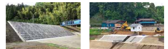
大柿排水樋管付近(5月16日時点)
