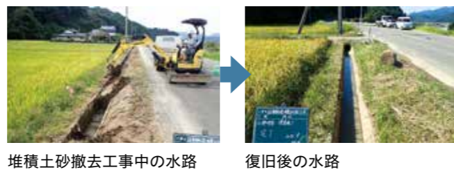
堆積土砂撤去工事中の水路
