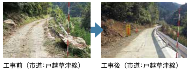
工事前(市道:戸越草津線)
