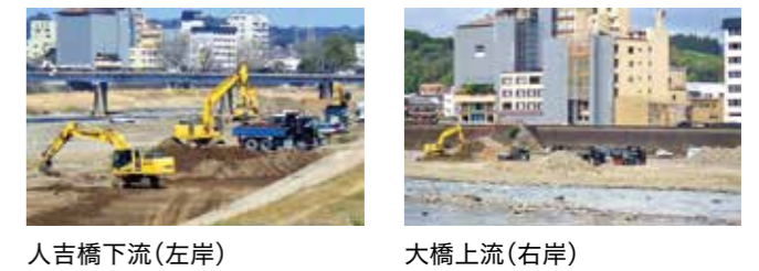
人吉橋下流(左岸)
