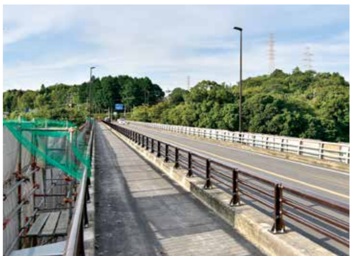
長寿命化への工事が進む曙橋
