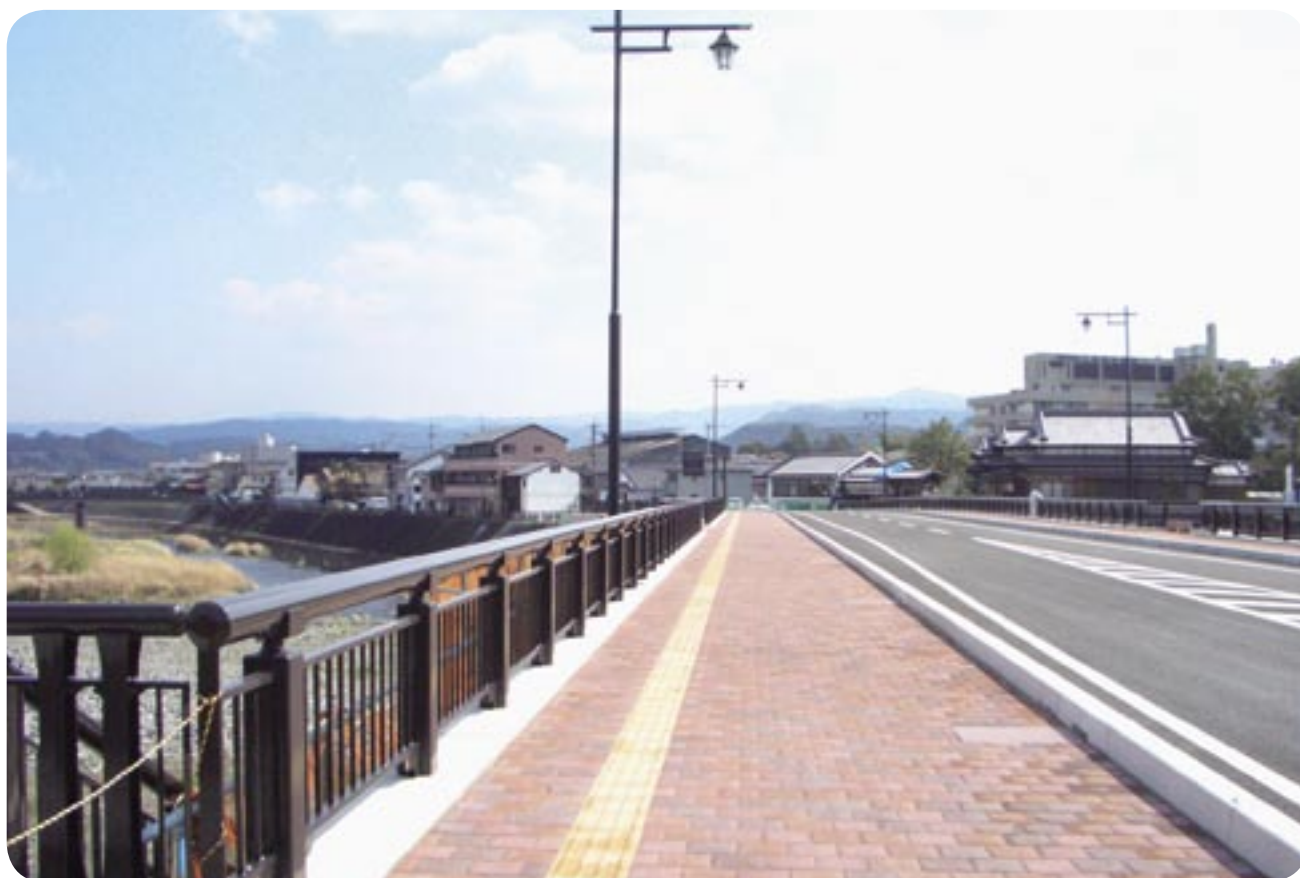
4月20日の完成式を間近に控えた大橋（九日町側から）
