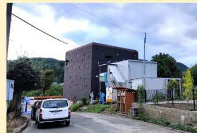
頭無川雨水ポンプ場
