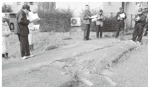
改修工事が行われる下薩摩瀬地区農道
